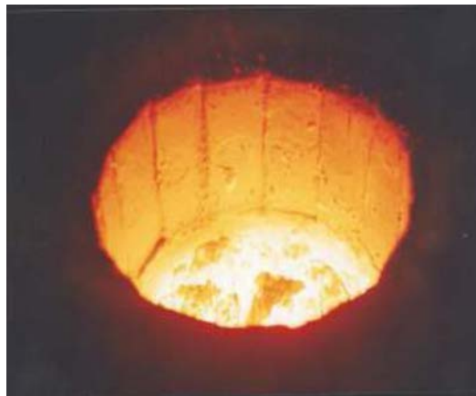
Футеровка бариевой ванны с использованием кладочного раствора КР-10 и защитного покрытия М-10 (ОАО «Коломенский завод»)
